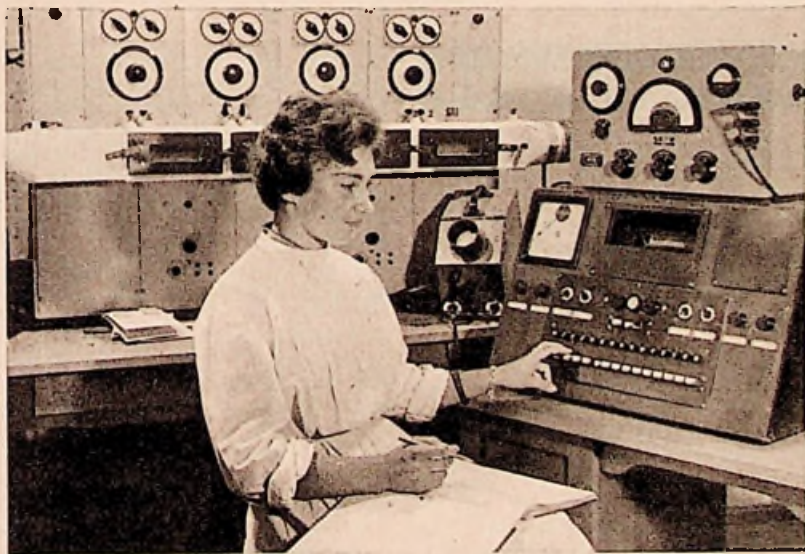
Messung des Temperaturkoeffizienten von keramischen Kondensatoren. Rechtes Foto: Temperatur-Meßschrank für einstellbare Temperaturschleifen im Bereich von etwa -65° C ... +80° C
